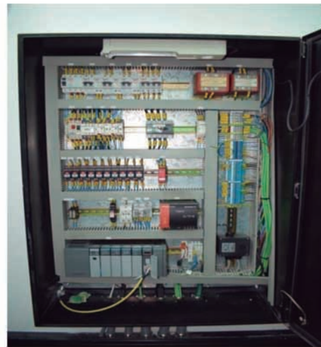
Cuadro eléctrico abierto
