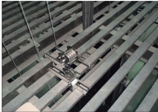
Riesgo de lesión al caminar sobre perfiles del peine
