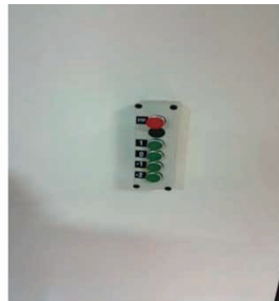
Botonera exterior del montacargas
