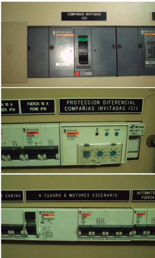
Protecciones en cuadro general de BT
