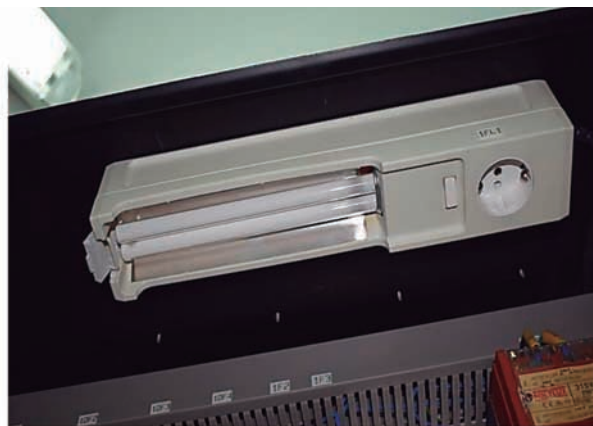
Iluminación en el interior del cuadro de maniobra y toma de corriente
