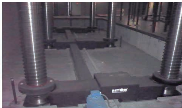
Se debe señalar la protección perimetral del foso elevador
