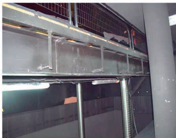
Iluminación de foso
