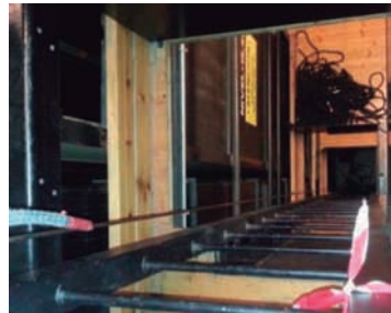
Escalera fija de dos montantes
