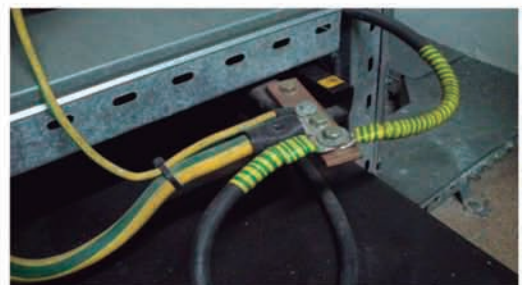
Detalle de puesta a tierra del GE
