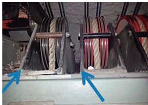
Cabrestante y poleas de cabeza fijadas a la estructura con soldadura
