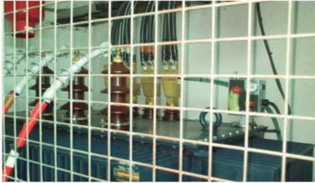
Centro de Transformación
