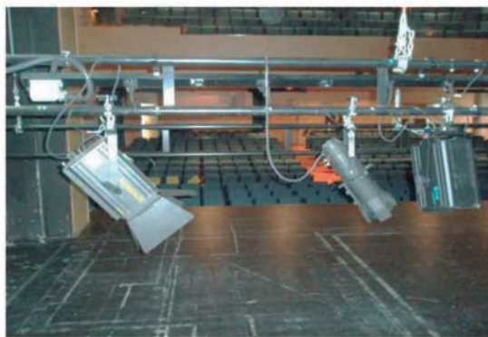
Sistema de iluminación
