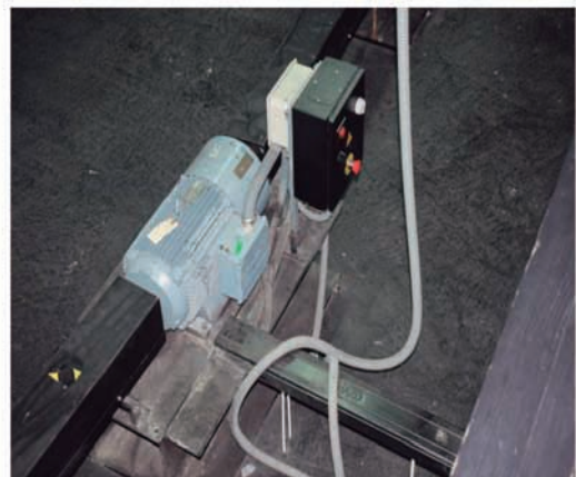
Cuadro eléctrico del foso con parada de emergencia
