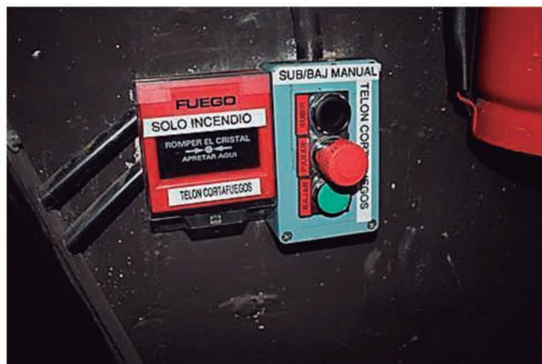
Sistema de accionamiento manual de un telón cortafuegos
