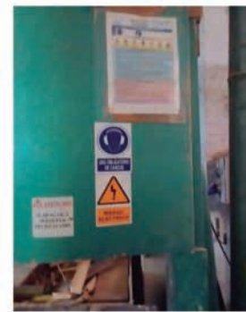
Señalización de seguridad
