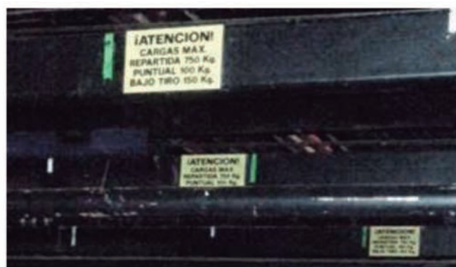
Señalización de capacidad de cargas en varas (se deben indicar los valores de carga repartida y puntual)
