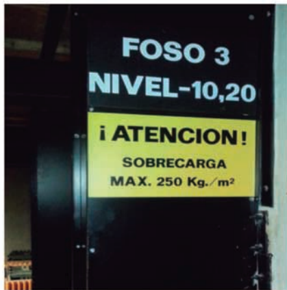
Señalización de sobrecarga en foso
