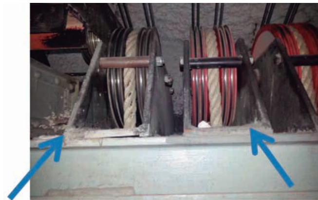
Poleas de cabeza fijadas a la estructura con soldadura
