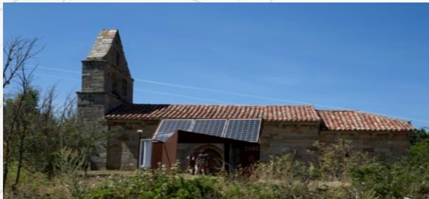
Paneles solares instalados en el exterior de la ermita de Santa María de Canduela (Palencia).
