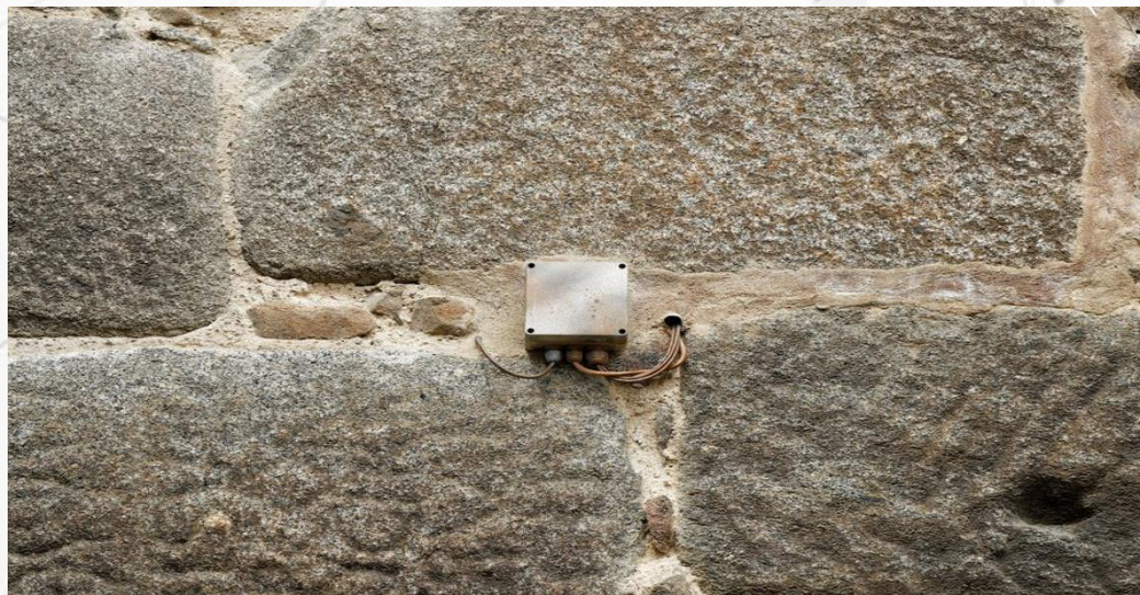
Sensor instalado en la muralla de Ávila.
